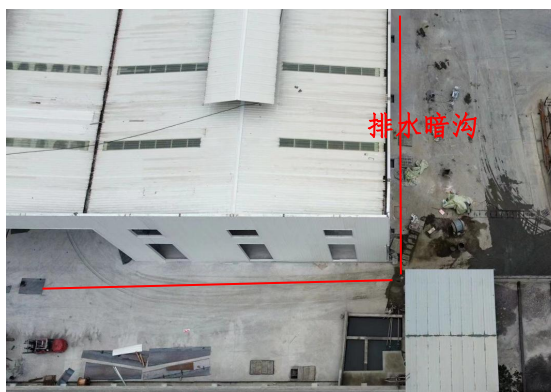
建构筑物周边设置的排水暗沟
